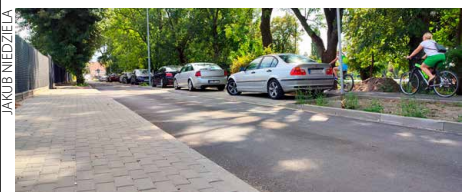
Ulica Barlickiego. Nowy chodnik, nowa nawierzchnia
